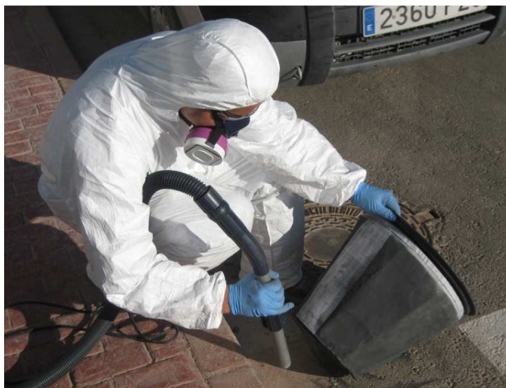
Figura 50 – Procedimento de limpeza dos filtros – Fonte: Tomada pelo autor
